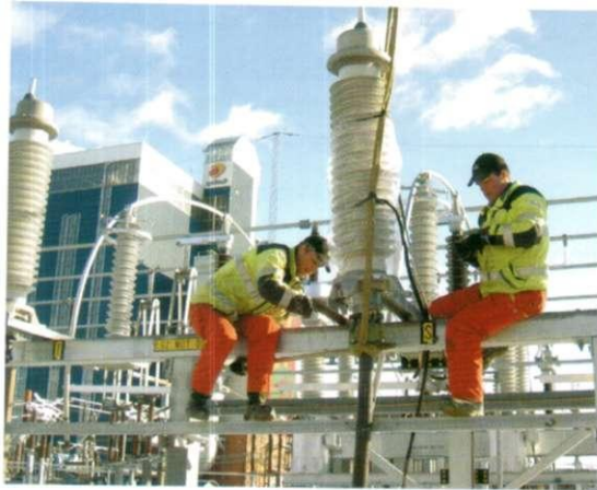
APESB-P 145 кВ с силиконовым изолятором, Швеция.
