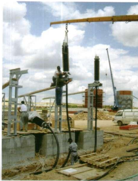
APESB с фарфоровым изолятором, сборка в горизонтальном положении с дальнейшим поднятием на место, Греция.
